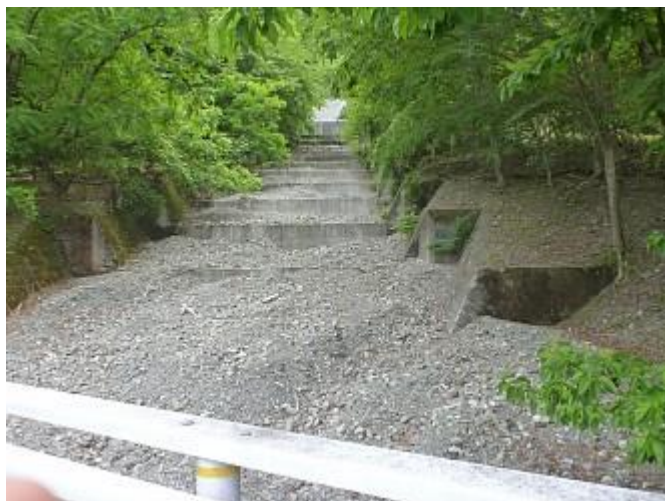
右 道路脇に見る小さな沢の「砂防堰堤」群
