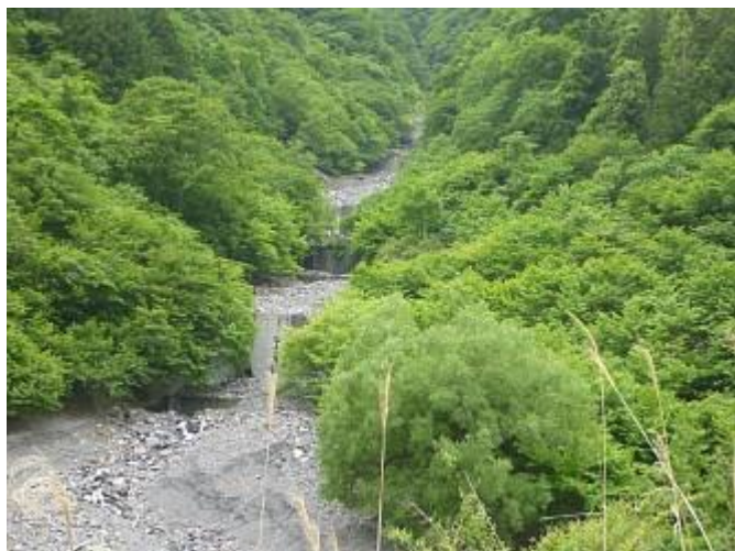
左 対岸の、通常は水流が無い場所の「砂防堰堤」
